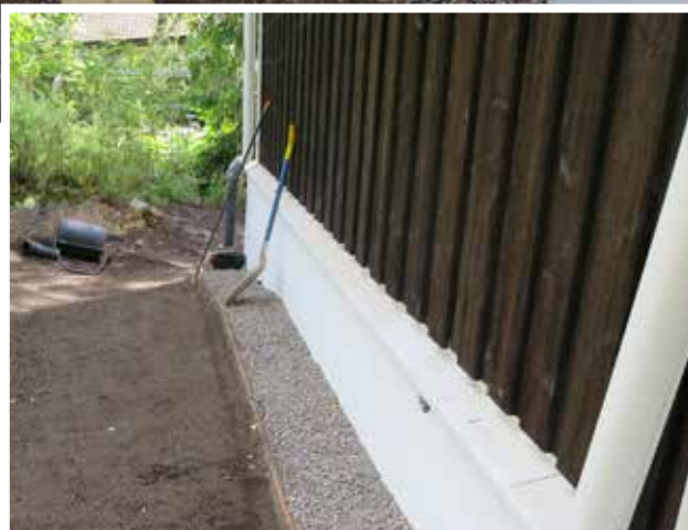
Kellarin seinän eristyskerroksen rakentaminen seinän ulkopintaan. Eristeleven päällä on peltiä.
