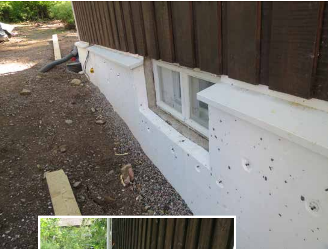
Kellarin seinän eristyskerroksen rakentaminen seinän ulkopintaan. Eristeleven päällä on peltiä.
