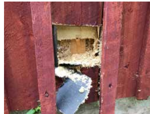
Puruista otettiin mikrobinäytteet. Purueristeissä oli kosteusvaurioon viittaavia mikrobeja.
