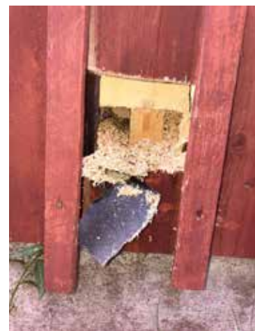
Onneksi purueristeiden sisäpinnassa oli normaali pahvi eikä pah-yhdisteitä sisältävää tervapaperia. Seinärakenteen voi korjata ulkokautta uusimalla seinän lämmöneristeet ja julkisivuverhouksen.
