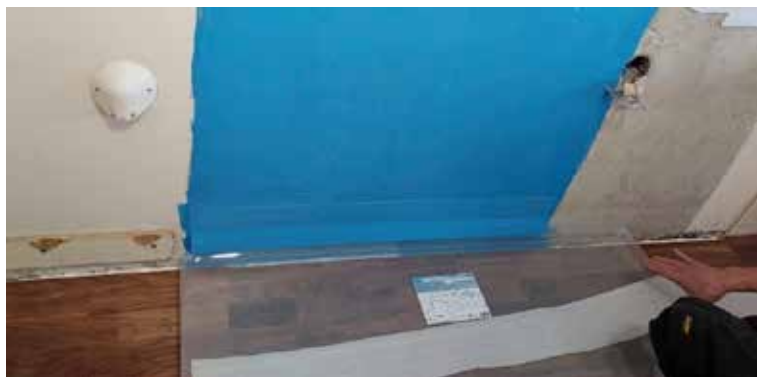
Vuotokaukalo on asennettu valmiin lattiapinnoitteen päälle ja tiivistetty seinän vedeneristykseen.
