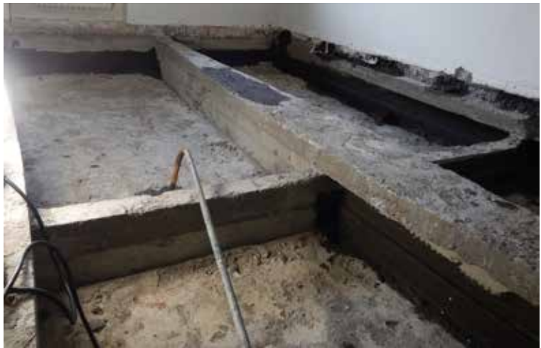
Betonirakenteet on puhdistettu mekaanisesti ja valujen sisällä olleet puutarvikkeet on kapseloitu Ardex 8+9 -tiivistysaineella. Alalaattapalkin venen muotoinen rakenne näkyy kuvassa.
