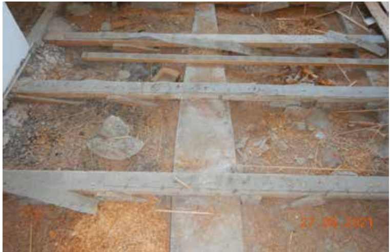
Pontattu puulattia on purettu. Laattapalkiston "venepalkit" näkyvät kuvassa. Täyttömateriaaleina ovat puru ja rakennusjätteet.
