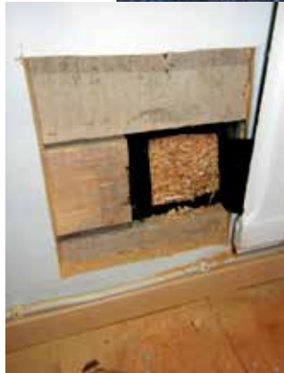
(Kuvat ylh. ja oik.) Seinien rakenteiden tutkimusaukkoja.
