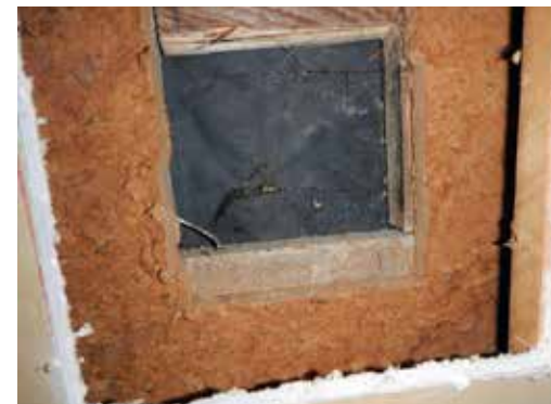
(Kuvat ylh. ja oik.) Seinien rakenteiden tutkimusaukkoja.
